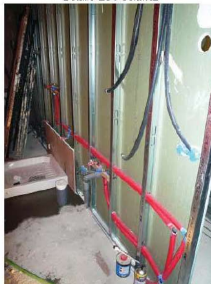
Detalle ESV-03.a.R3. Instalación correcta de las tuberías entre los perfiles de las placas de yeso laminado.
